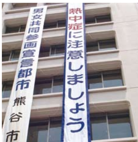
市庁舎には、熱中症啓発の懸垂幕。ちなみに市庁舎の窓は、北側を除き、熱反射・断熱フィルムが貼付されている
