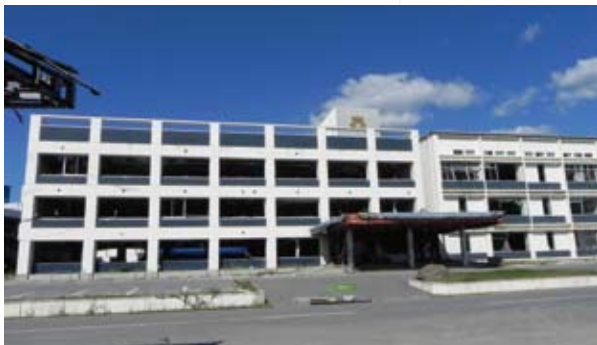
海から約1.5kmの距離にあった、かつての陸前高田市役所。3階まで水没し、屋上ぎりぎりまで津波が迫った。現在は解体され、山間部に仮庁舎が建てられている。
