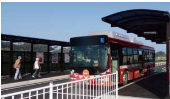
流出したJR大船渡線に替わり、BRT（バス高速輸送システム）が運行を開始。JR小友駅では、流出した駅舎、線路に替わり、BRT駅と数百メートルの専用軌道が完成した
