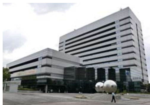
春日井市役所本庁舎。12階建ての北館と4階建ての南館からなり、延床面積は約42,000㎡に及ぶ。このほか議会棟も含め、本庁事業場安全衛生委員会の管轄となる
