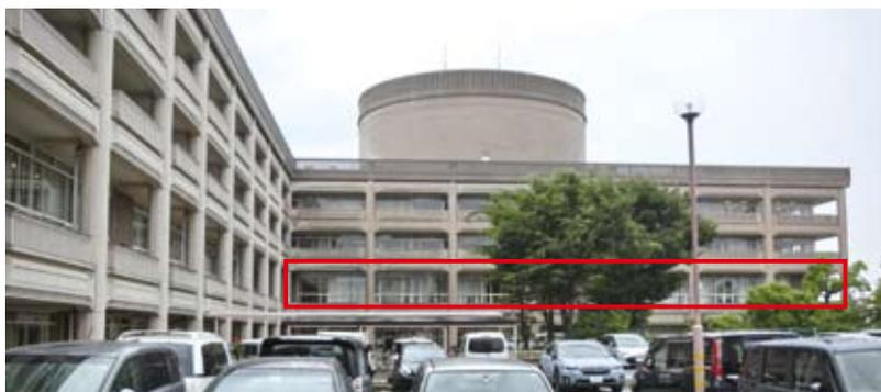
赤枠部分が焼損部分。防火扉により他ブロック・フロアへの延焼はまぬがれた。各フロアにめぐらされたベランダは、防火扉が下りたことで行き場を失った職員の避難路として機能した
