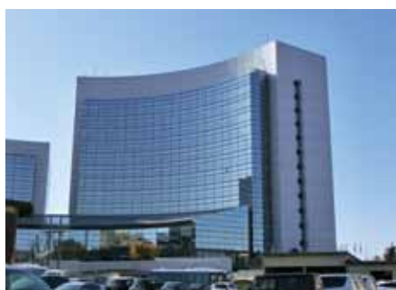
岐阜県市町村振興協会が入居する「岐阜県民ふれあい会館」(岐阜市)。ネーミングライツによる通称は「OKBふれあい会館」。研修センターの前身である財団法人「岐阜県市町村職員研修センター」は平成22年、岐阜県市町村振興協会と合併。24年に同協会が公益法人化したのに伴い、研修センターの正式名称も現在のものとなった
