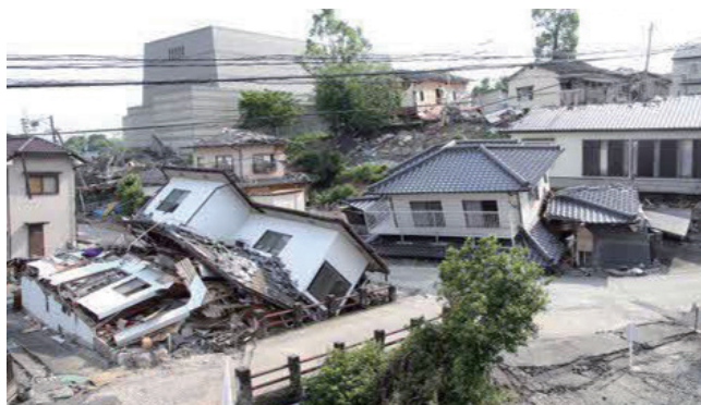
倒壊した家屋(寺迫地区)
