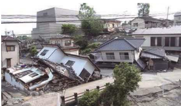
倒壊した家屋(寺迫地区)
