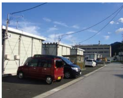
庁舎に隣接した仮設公舎。
