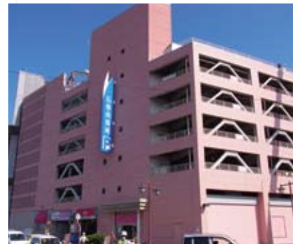
JR石巻駅前に建つ石巻市役所。駅前デパートを改装した建物として本誌2010年7月号で紹介している。津波で1階部分が水に浸った
