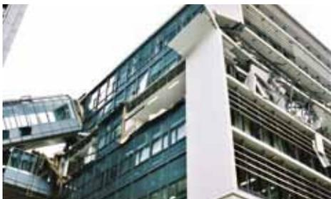
阪神・淡路大震災震災直後の市庁舎2号館。6階全体が崩壊、7階以上が1.5m北側にずれた。大規模改修のうえ、現在も使用されている
