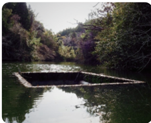
おおせぎざき 大関堰(大堰)
